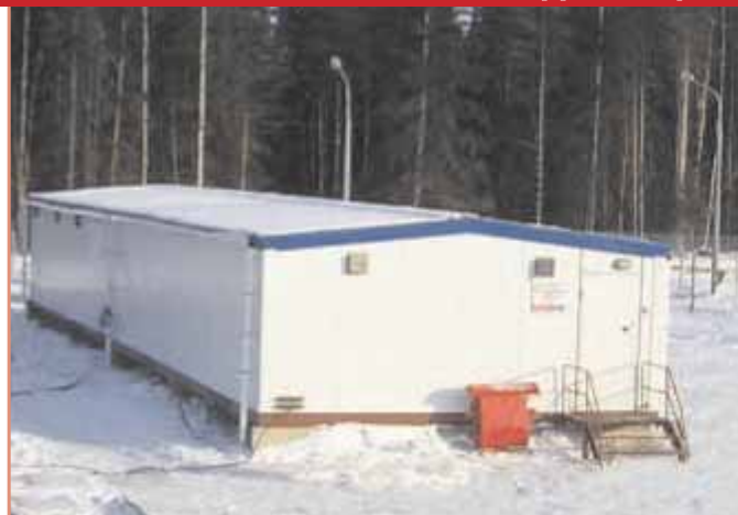
Общеподстанционный пункт управления
