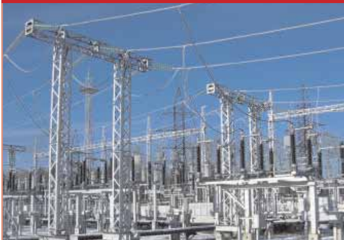
Подстанция комплектная трансформаторная блочная 110, 35 кВ
