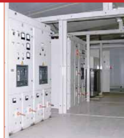
Размещение 2КТП в блочно-модульном здании
